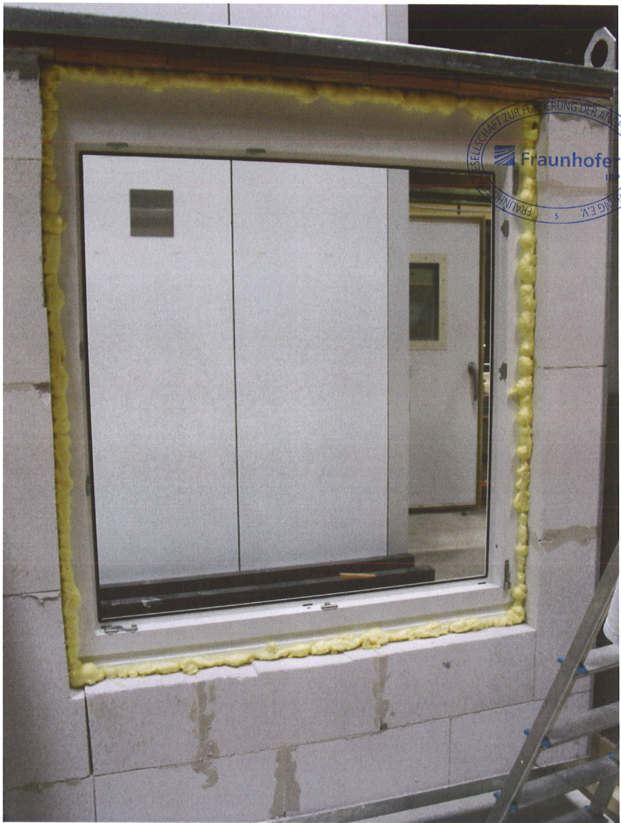
Bild 3: Einbau des Fensters mit Hilfe des PU-Dichtschaums „CLEAROPAG 167 Volumen-Aerosol-Klebstoff“.
